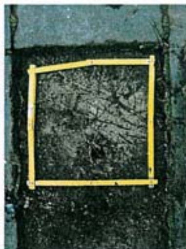
Abb. 6: Horizontale Wurzelverteilung unter Pflasterung.
